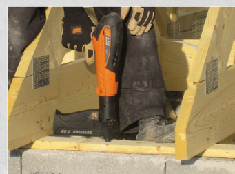
Houten latten / houtconstructie
